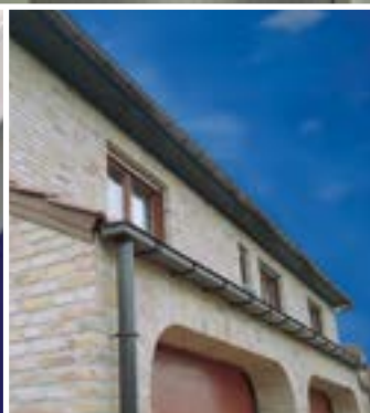
▲ renovatieproject - Tubize - B
