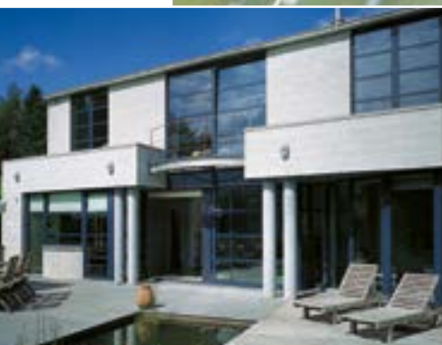
▲ nieuwbouw met Evaco® bakgoten - Brussel - B
