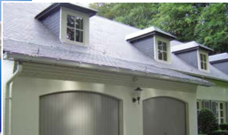
▲ dakrenovatie met Evaco® - Brasschaat- B
