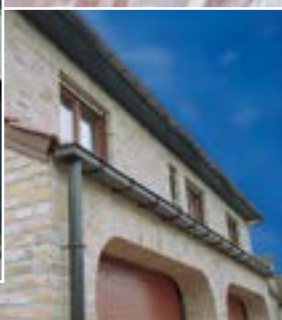
▲ nieuwbouw met Evaco® bakgoten - Tubize - B
